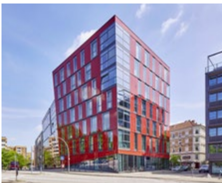
Dock 47, Hamburg, Bürogebäude
